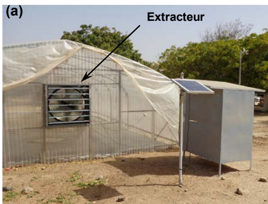
Photo 4. Vue des deux pignons de la serre avec extracteur (a) et volets mobiles (b)
